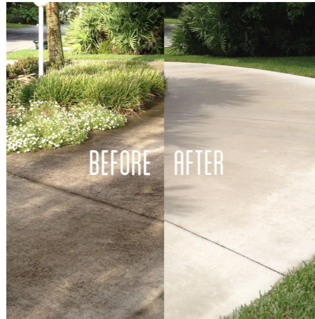
Krok I Čistenie jednotlivých prvkov vysokotlakým čističom.
